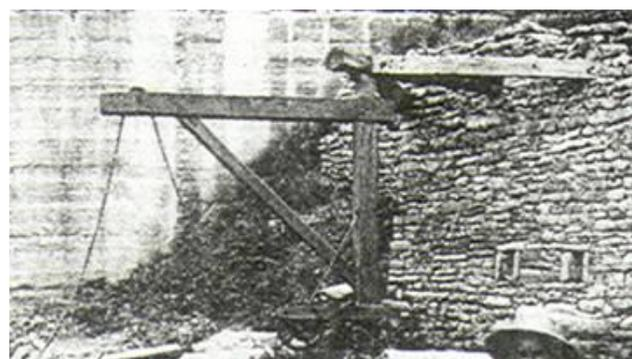
*Sapine : treuil de levage pour déplacement ou chargement des grosses pierres dans la carrière*
